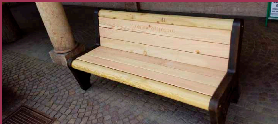
Rivestimento in legno delle panchine in ferro con scritta "Comune di Tesero"
