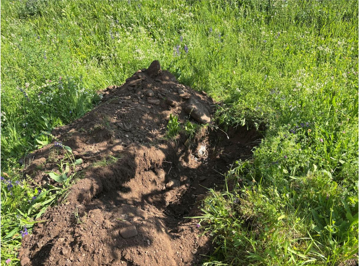
Fig. 8 – Fronte scavo del pozzetto geognostico
