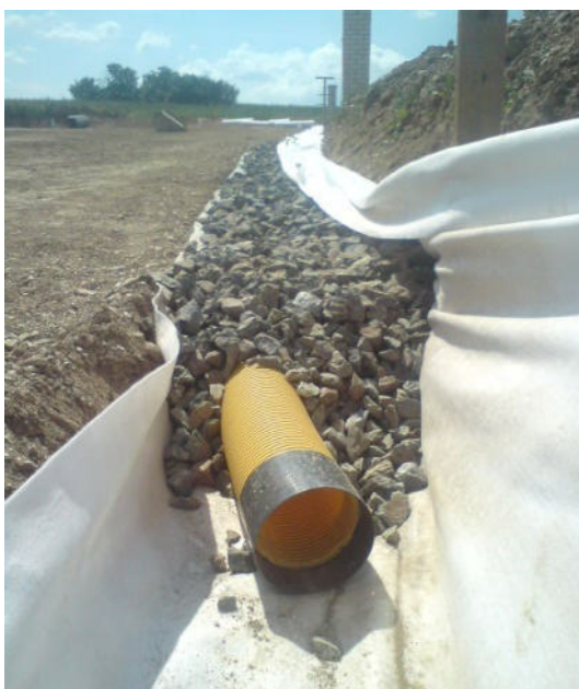
Immagine 30: esempio di trincea drenante
