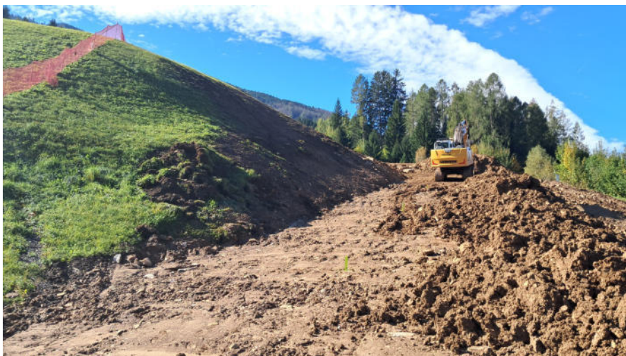
Immagine 32: fronti di scavo aperti per la realizzazione delle pista da sci con inclinazione 35°
