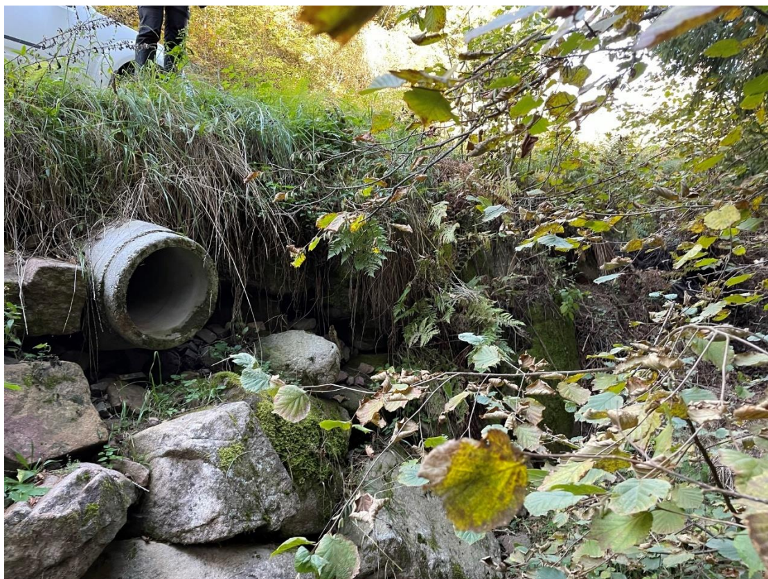
Figura 11: Rio del Maton, termine tubazione di attraversamento attuale della pista
