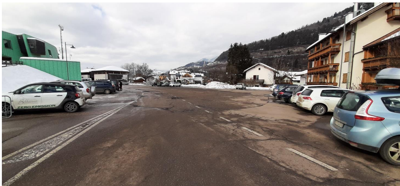
Parceggio principale antistante centro del fondo (vista verso ovest)
