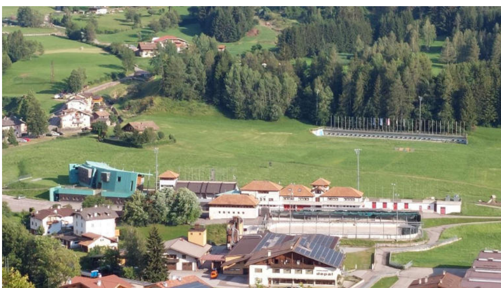
Immagine 8: panoramica dell'area d'intervento
